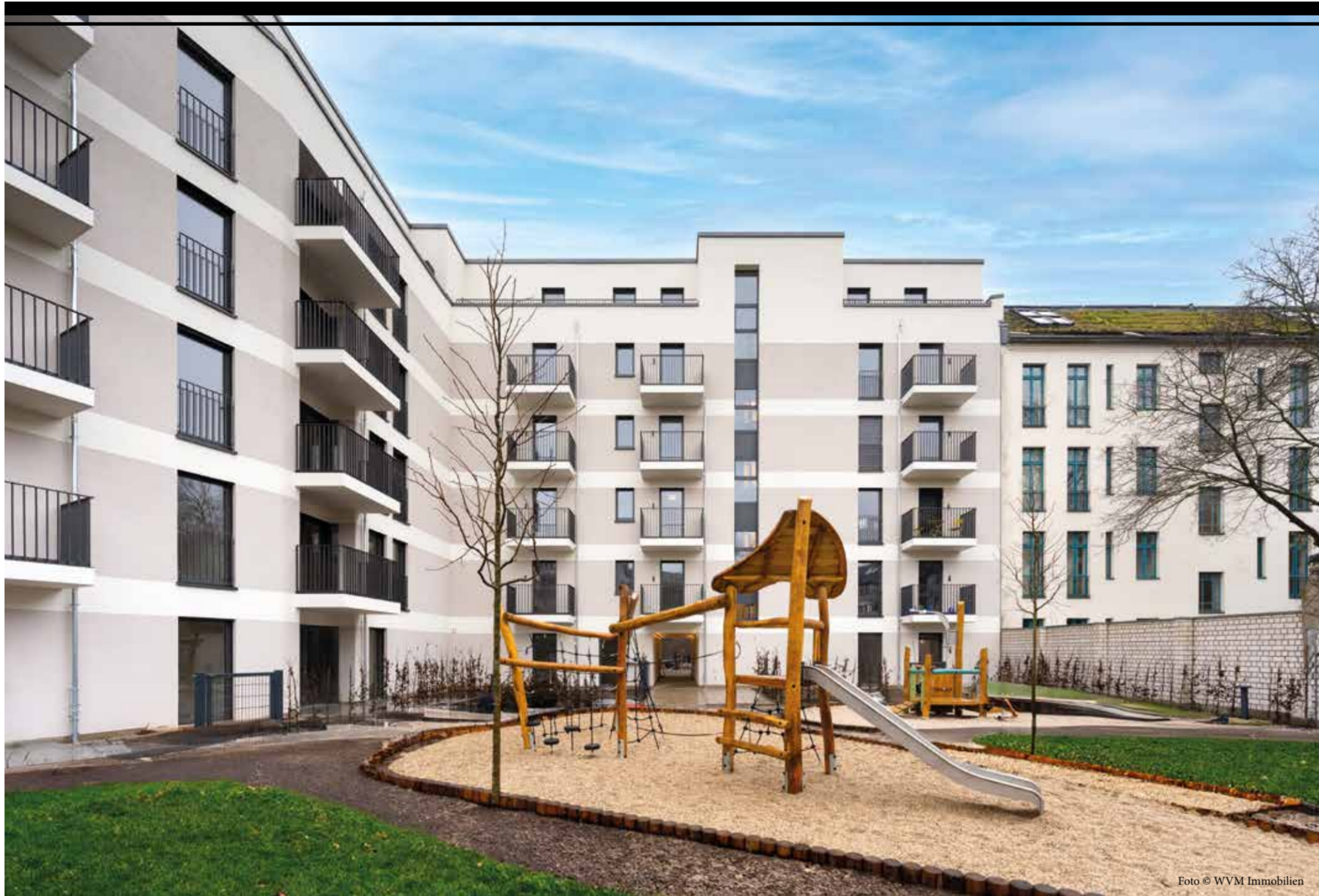
In Berlin-Weißensee entstanden in einer Baulücke 80 Wohneinheiten
