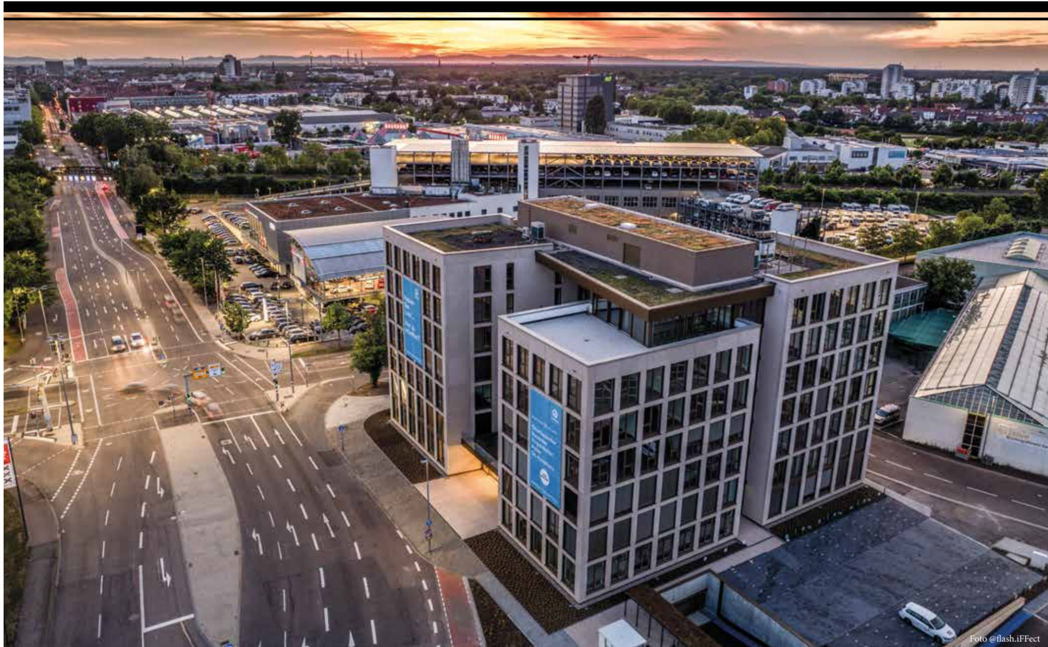
Der CarlsCube: Ein zukunftsweisendes Bürogebäude in der boomenden Karlsruher Oststadt.
