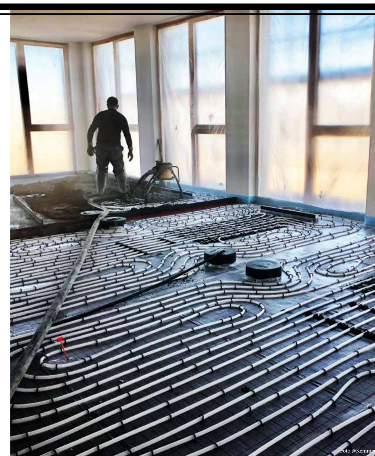
Einbringen des Estrichs auf fertigem ClimaLevel Multiboden.
