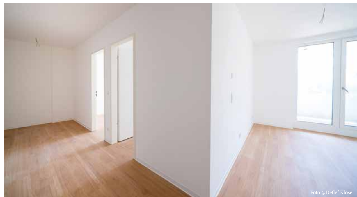
ClimaLevel stattete sämtliche Wohnungen im Dolgensee-Center mit Fußbodenheizung aus.
