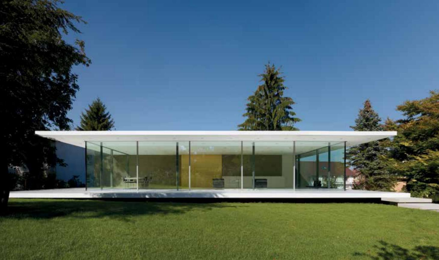
Auch bei D 10 ist gestalterisch das Prinzip maximaler Transparenz prägend. Die über dem Erdreich schwebende Bodenplatte ist gleichermaßen Terrasse wie Fußboden und schafft eine optische Kontinuität von Innen- und Außenbereich. Die geschosshoch verglaste Außenfassade lässt die Grenzen von innen und außen fast vollständig verschwinden und gewährt freie Sicht auf den alten Baumbestand des Grundstücks.
