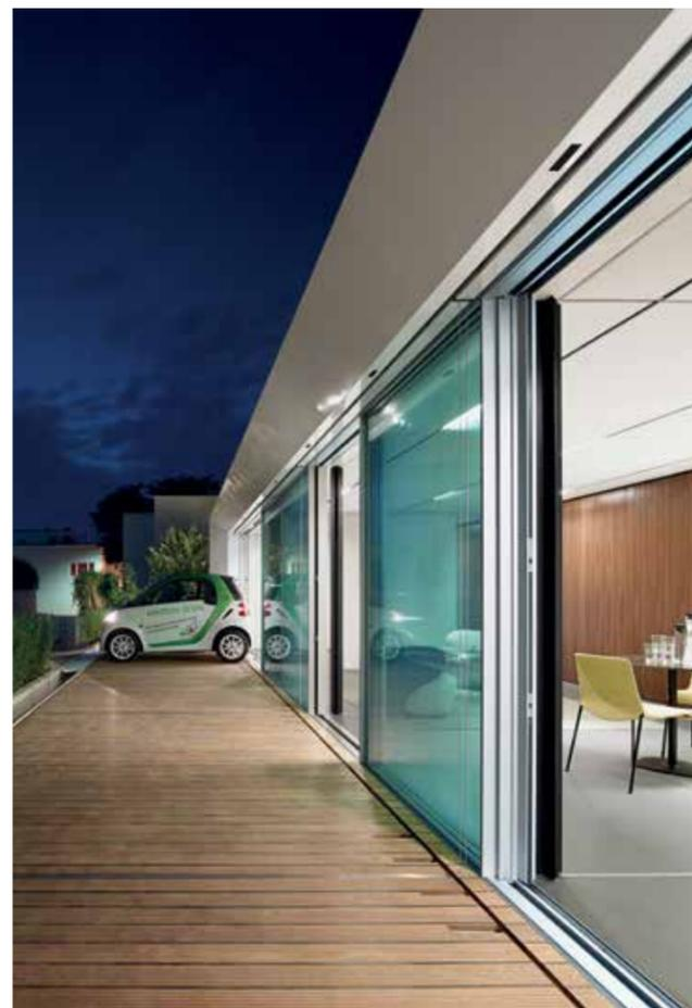
Der Baukörper von B 10 ist auf drei Seiten vollständig geschlossen, während die Westfassade aus vier nach unten klappbaren Wandelementen besteht. Im hochgeklappten Zustand garantieren sie eine maximale Wärmedämmung, heruntergeklappt fungieren sie als Terrasse.
