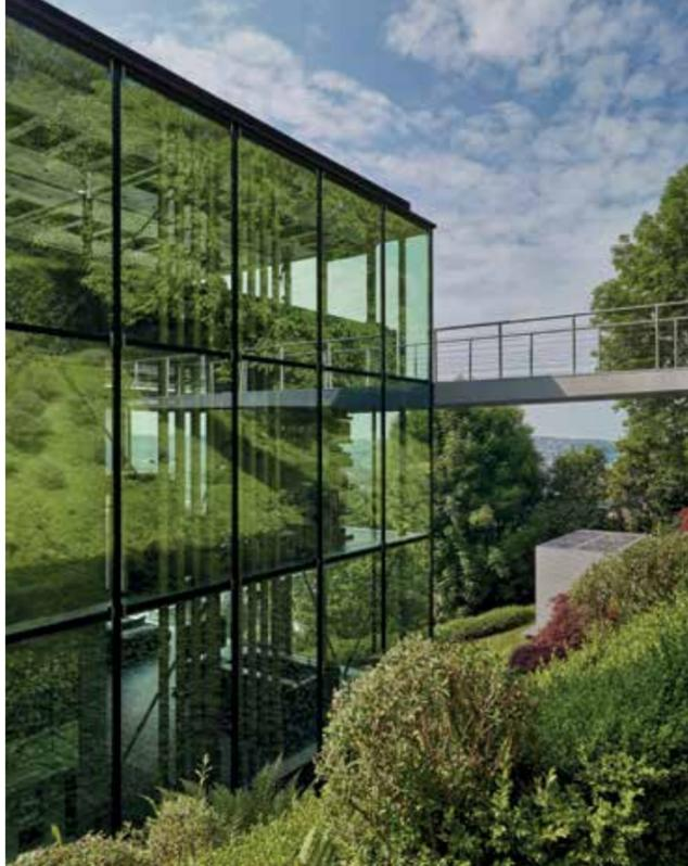
Eingepasst in „unberührte“ Natur: Das Haus R 128 liegt an einem steilen Hang und wird von einem sorgfältig geplanten, üppigem Garten eingerahmt. Alle Erschließungswege zum Haus und die Terrassen „schweben“ in 20 cm Höhe über dem Boden, um die Natur möglichst unberührt zu lassen. Aus diesem Grund ist das Gebäude auch nicht unterkellert und verfügt über keinerlei Bodenleitungen.
