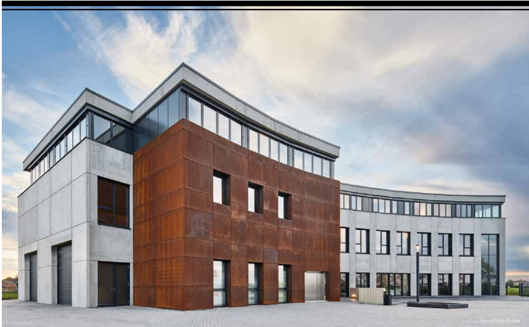
Eine Teilverkleidung mit Cortenstahl akzentuiert die klar gegliederte Fassade
