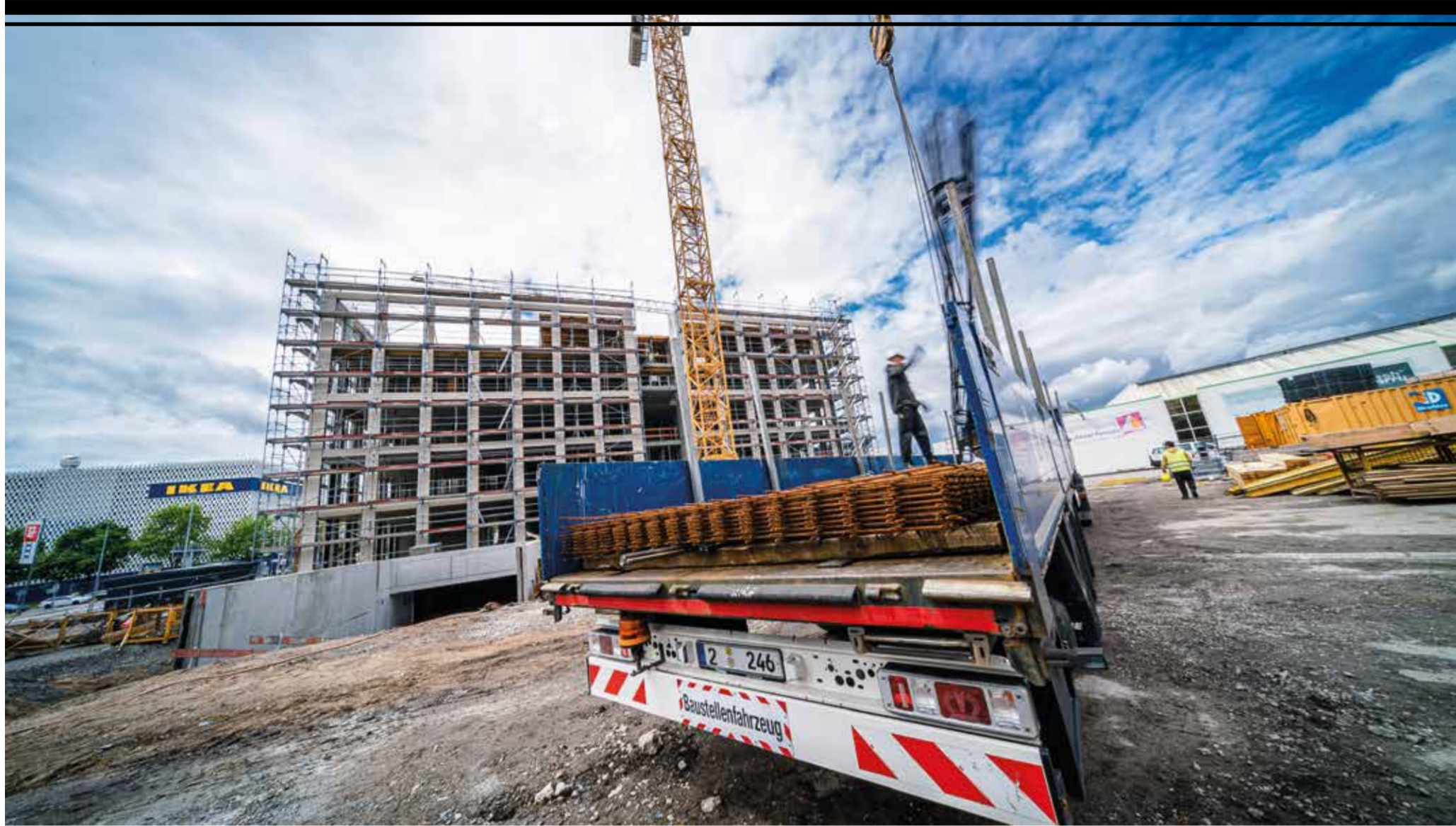
Fertigteile aus Architekturbeton lassen das Bürogebäude schnell in die Höhe wachsen
