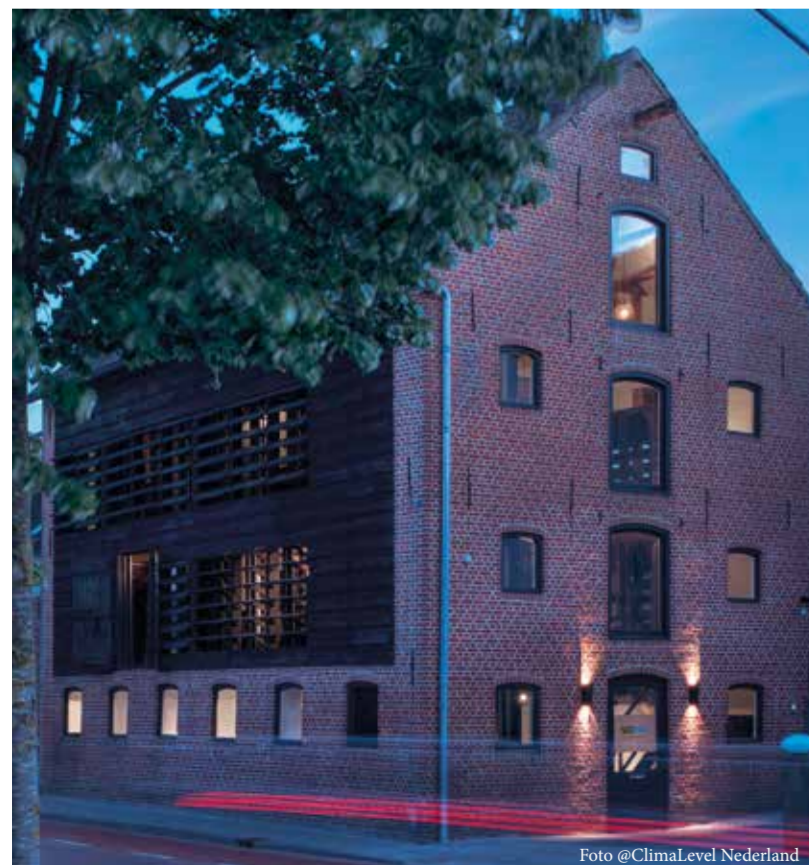
Das Äußere blieb weitestgehend unangetastet
