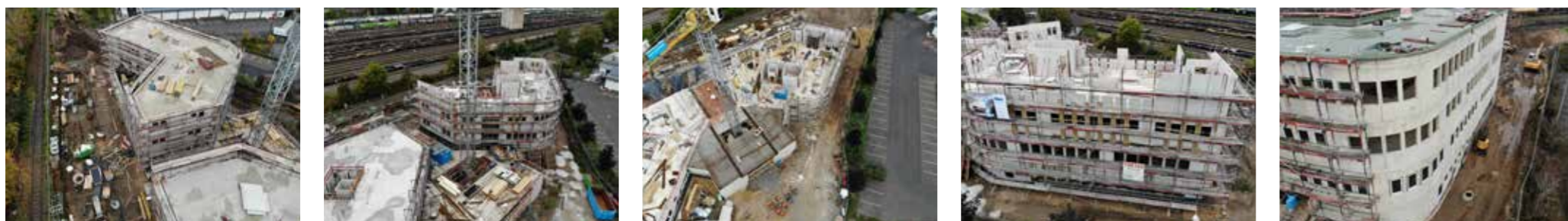
Die Gebäude nehmen Gestalt an. Im Sommer sollen sie bezugsfertig sein.
