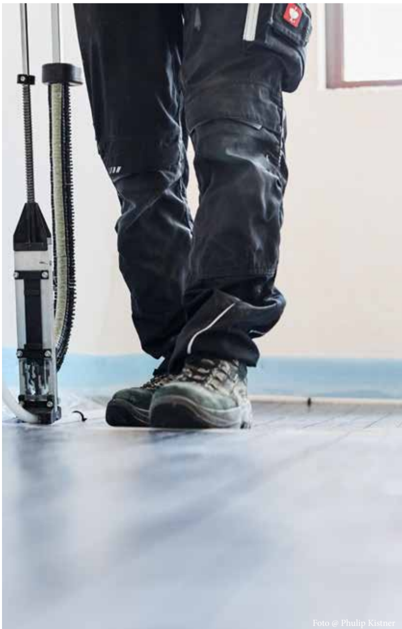
Die Verlegung der Heizrohre.
