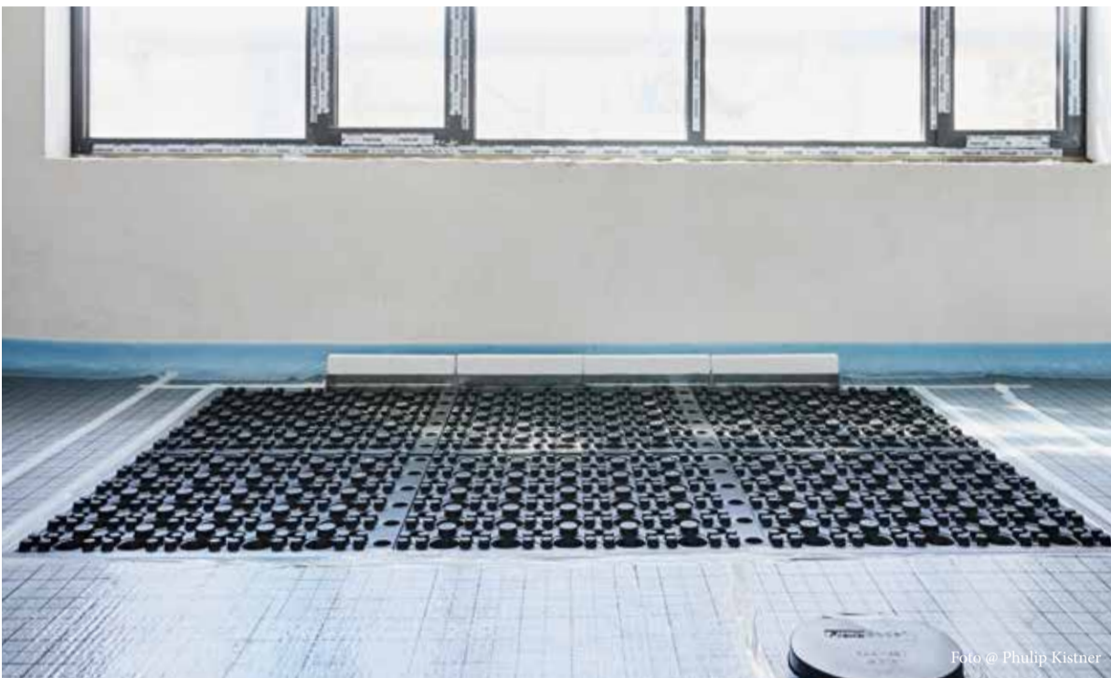
Die für die Heizrohrverlegung vorbereitete Fläche.
